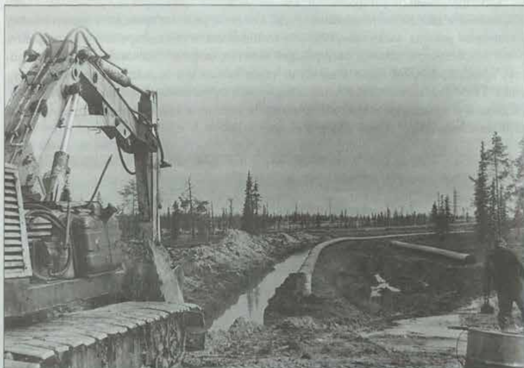
Строительство нефтепровода Возей - Уса.
