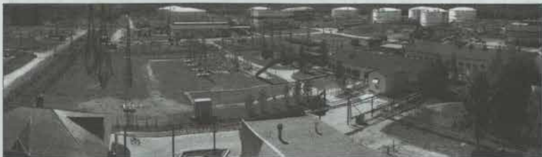
Ухтинская нефтеперекачивающая станция.
