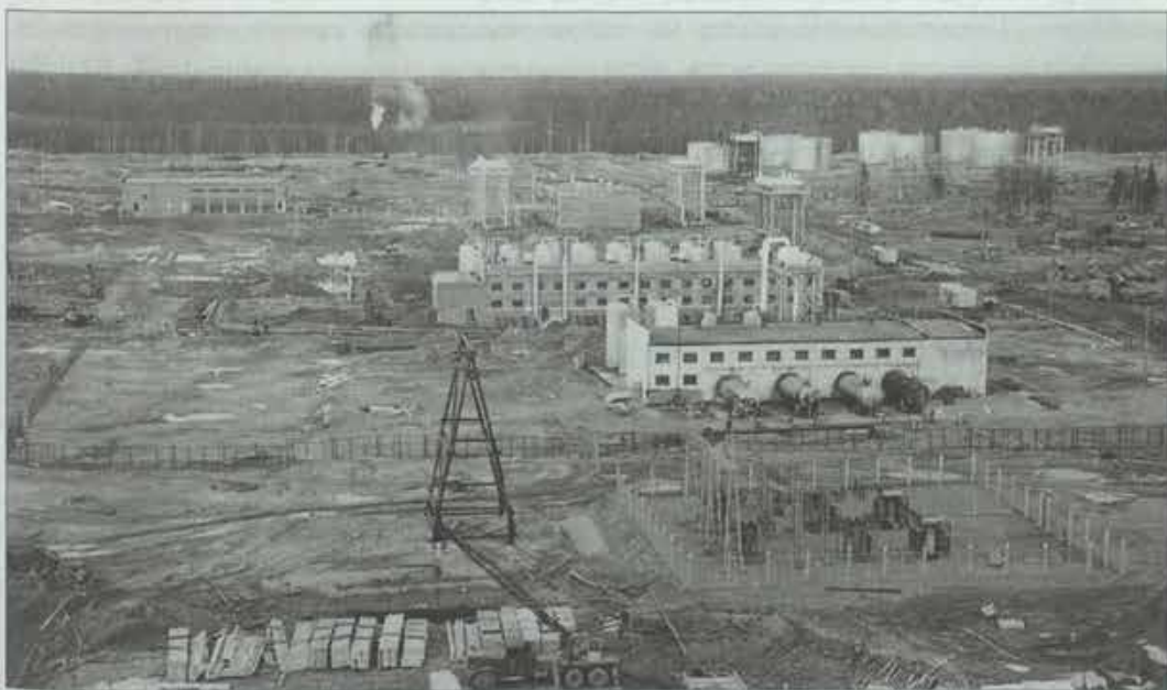
В стадии строительства головные сооружения. Вуктыль, 1969 год.
