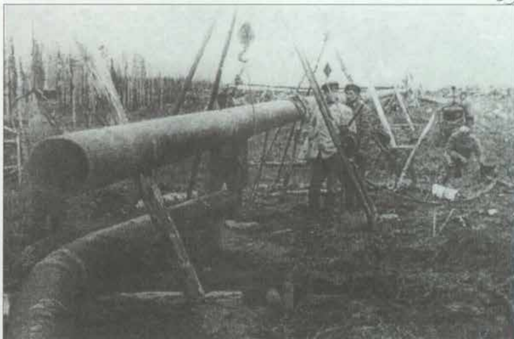
Монтаж подвесного газопровода Войвож — Ухта. 1946 год.
