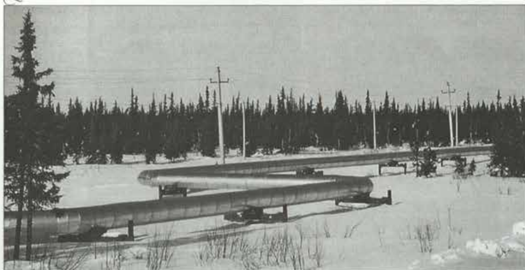
Наземный экспериментальный нефтепровод Харьяга — Северный Возей.
