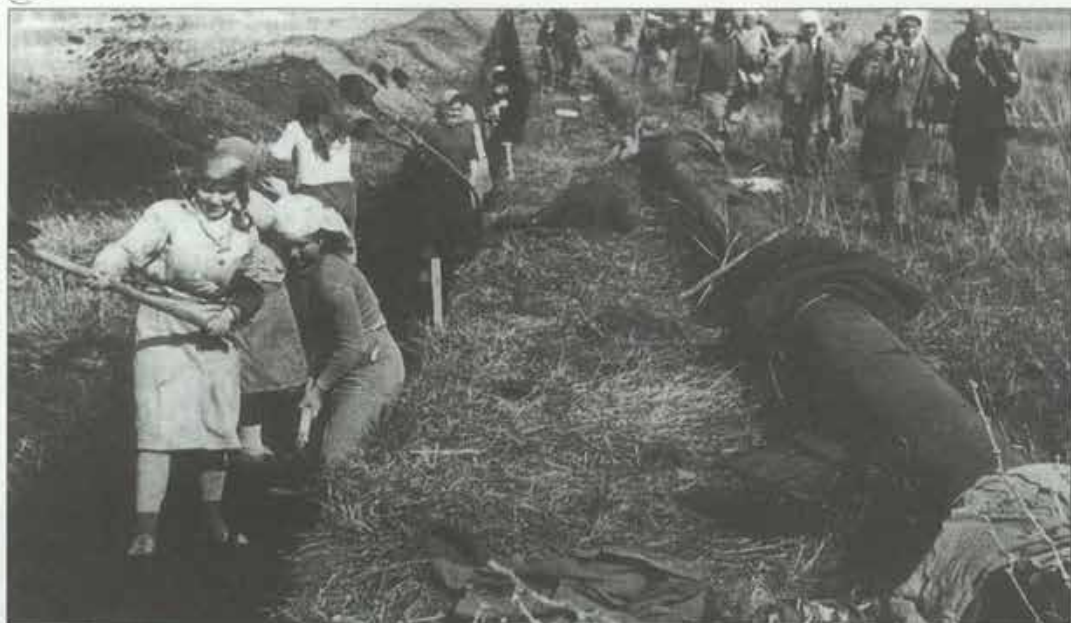
Строительство газопровода Саратов — Москва. 1946 год.
