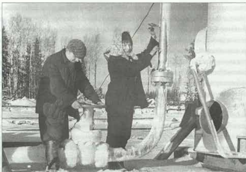
Оператор Владимир Гавриков и техник Лидия Дятлева открывают задвижку на скважине №11, откуда первые кубометры газа поданы в газопровод Вуктыл — Ухта. 1968 год.
