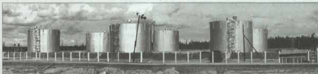
Панорама базы метанола и горюче-смазочных материалов, где произошел взрыв резервуара с метанолом.
