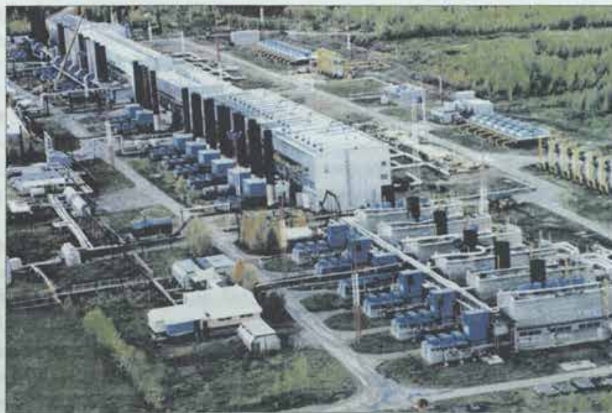
Панорама газотранспортной компрессорной станции на трассе газопровода «Сияние Севера»
