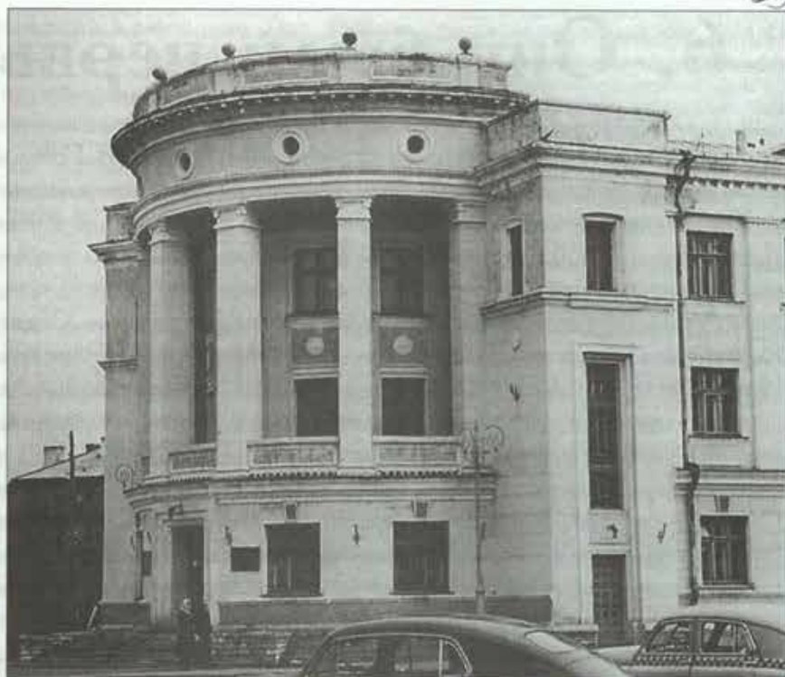
Ухта. Лесотехникум, построенный в 1950 году. Архитекторы Жижимонтов, Мурзин.
