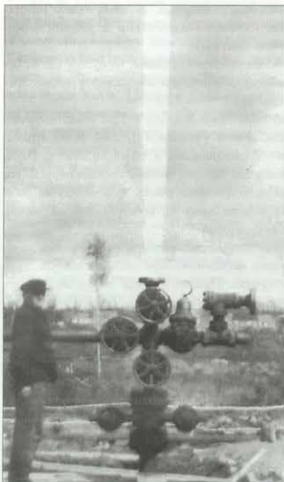
Седельское месторождение. Продувка скважины. 1950 год.
