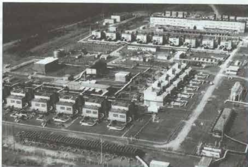
Вуктыльская газокompрессорная станция №3.
