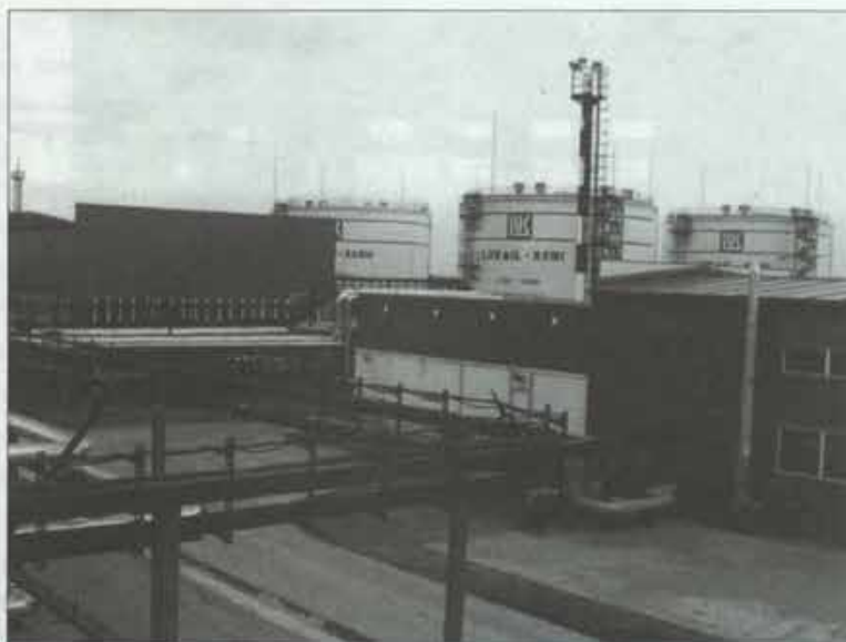
Дождимая насосная станция ДНС-7 на Воейском месторождении входит в систему сбора, подготовки и транспорта товарной нефти.
