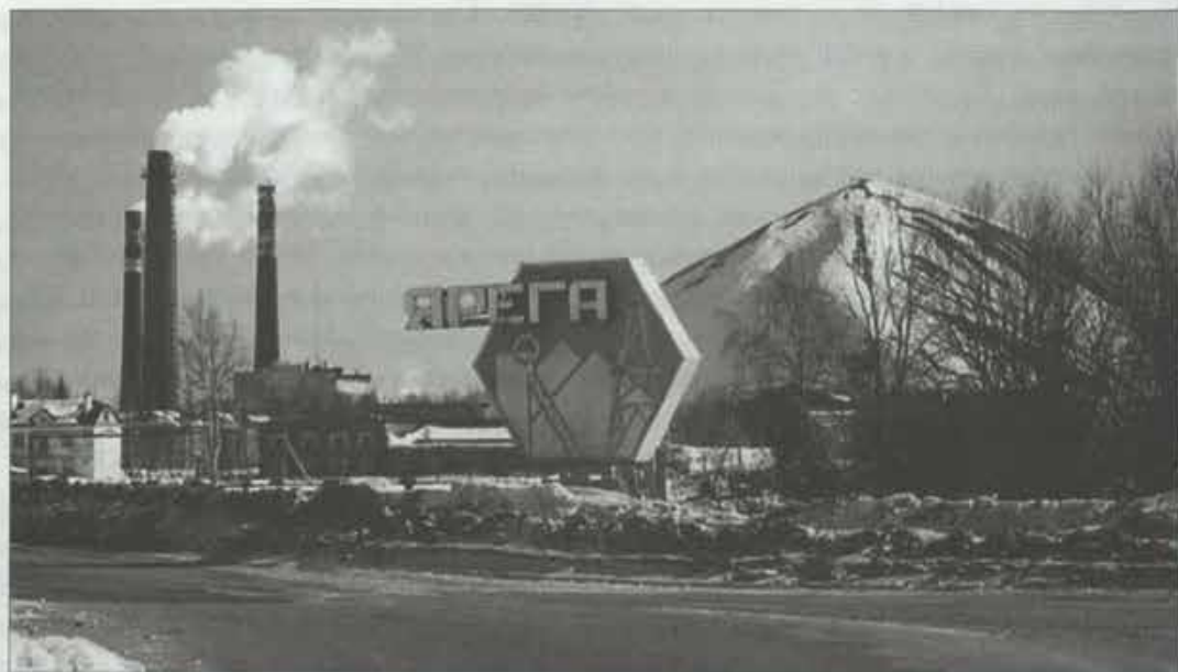
Поселок Ярега. Нефтешахта №1.
