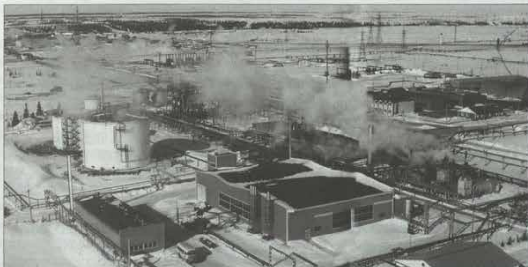
Панорама промышленного комплекса на Харьягинском месторождении.
