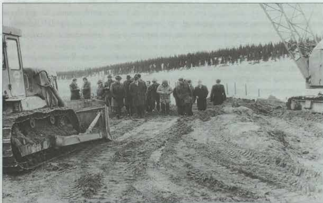
В гостях у строителей пятого моста через реку Колва на Харьягинском месторождении.
