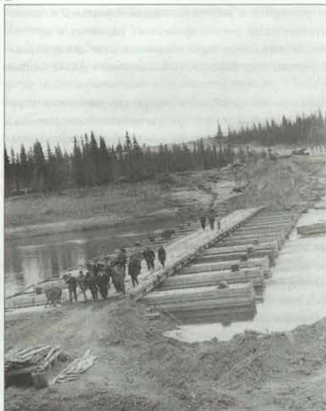
Понтонная переправа в районе Северного Возья. 1982 год.
