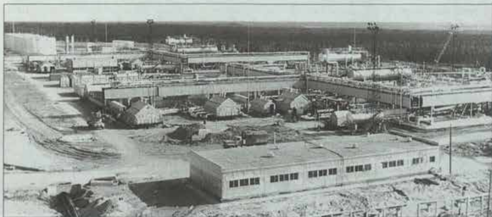
Усинско-Воейская установка подготовки нефти.
