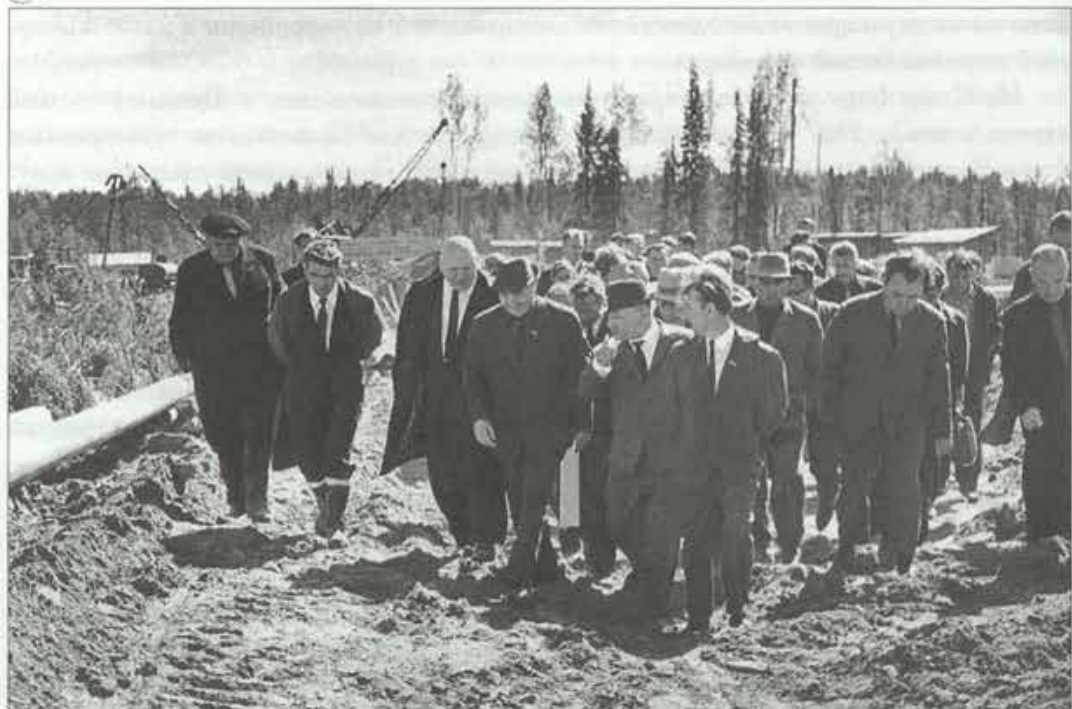
Начало грандиозной стройки.
