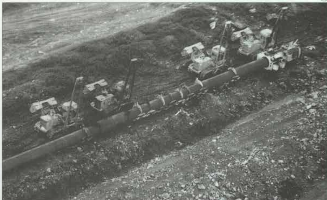
Строительство газопровода через Полярный Урал. Вуктыльский район Республики Коми.
