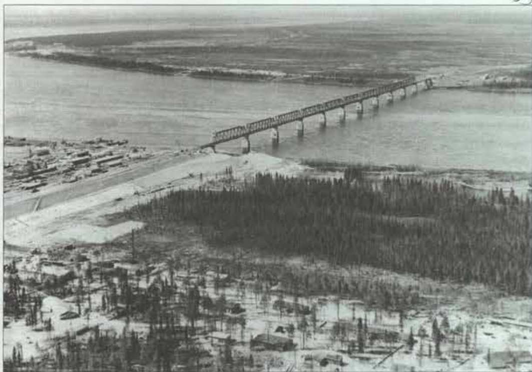
Мост через реку Уса к северным месторождениям нефти и газа.
