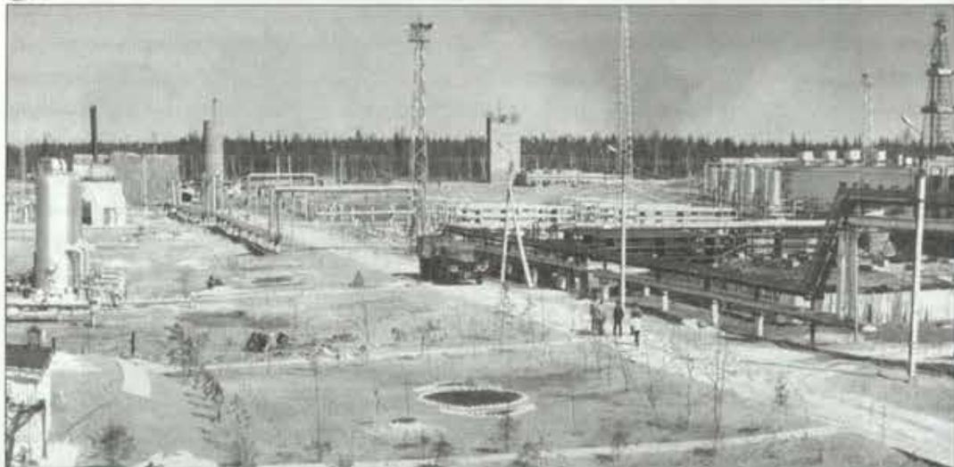
Установка комплексной подготовки газа — УКПГ-2. 1974 год. На заднем плане печально знаменитая буровая скважина №38.
