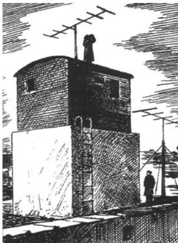
Рис. 2.6-13. Радиолокационная установка и антенна передающего центра на здании НИИ-9 (Реконструкция).
