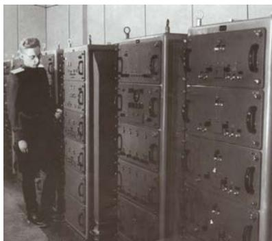
Рис.2.11-76 Размещение главных усилителей сигналов-ответчиков ракет, систем опорных напряжений и распределителей маркерных меток индикации станции Б-200
