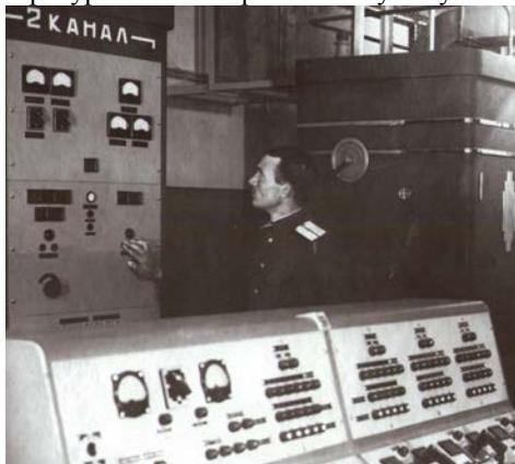
Рис. 2.11-74 Размещение приёмопередающей аппаратуры и пульта управления станцией Б-200
